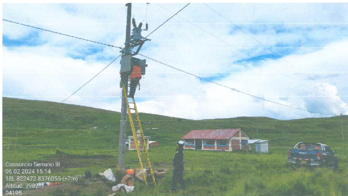
Foto N° 11: Verificación de Instalación de tableros de distribución – Sector Pampas II.
