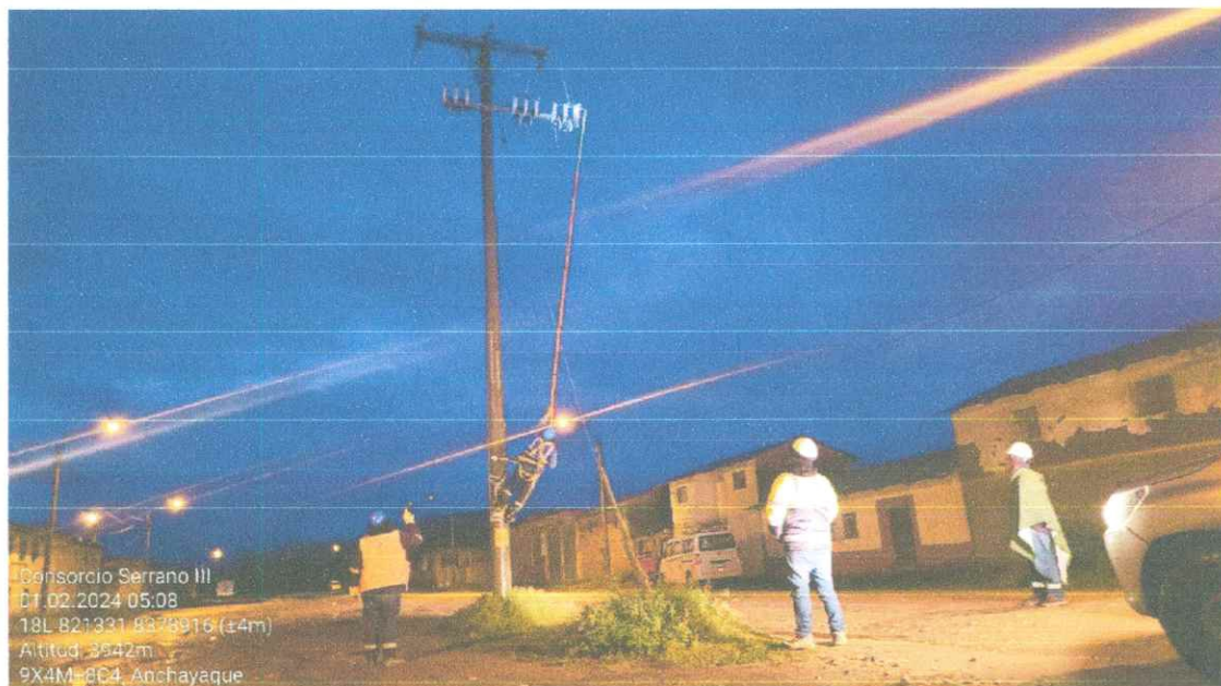
Foto N° 01: Inspección del proceso de corte de Energía, cumpliendo las 5 reglas de oro - Pulpera
