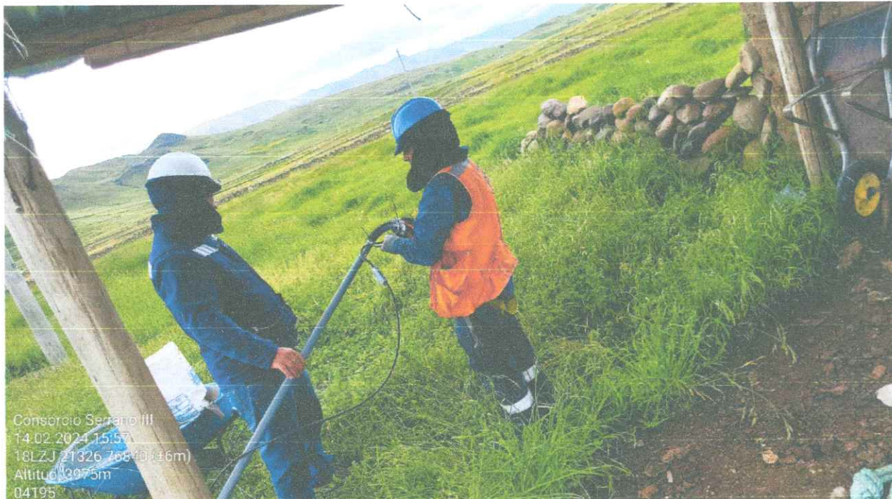
Foto N° 23: Verificación de bastones PVC de acometidas domiciliarias previas a la instalación.
