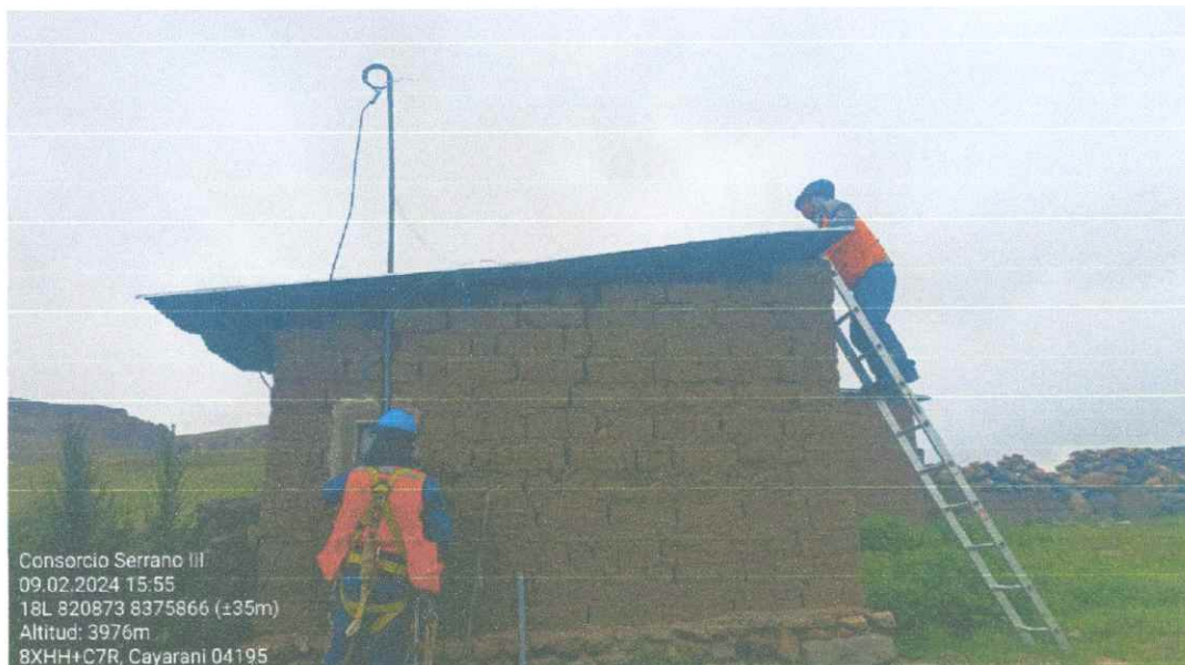
Foto N° 19: Instalación de acometidas domiciliarias - Conexión Corta
