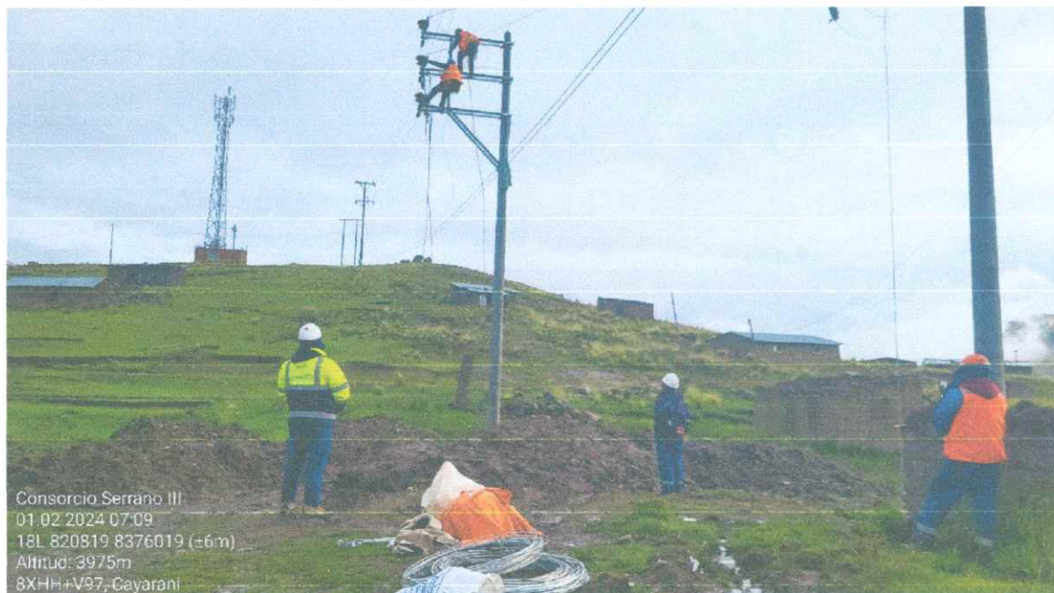
Foto N° 03: inspección del reflechado de línea primaria para la adecuación derivación – Sector Carayani.
