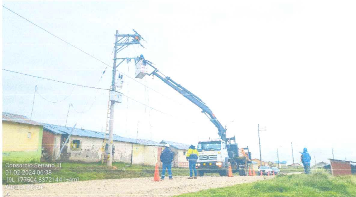
Foto N° 04: verificación de Conexión de derivación a línea nueva – sector visca visca
