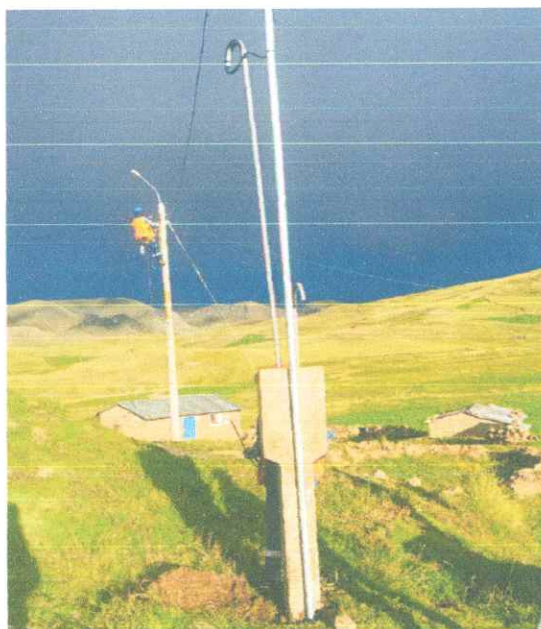
Foto N° 20: Instalación de acometidas domiciliarias con MURETE, conexión larga.
