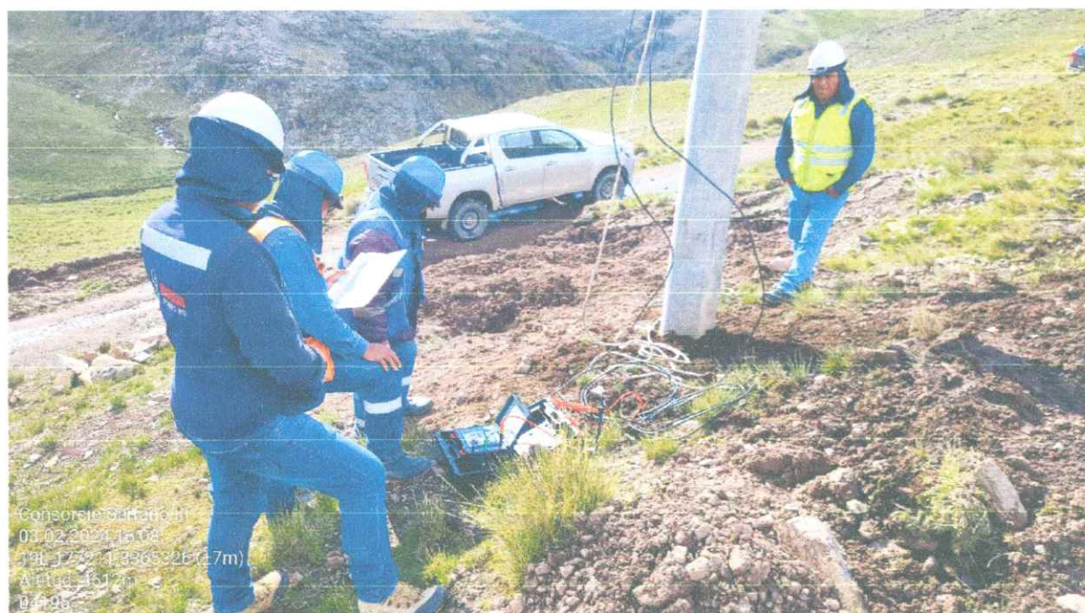
Foto N° 08: Pruebas de aislamiento y continuidad de líneas primarias.
